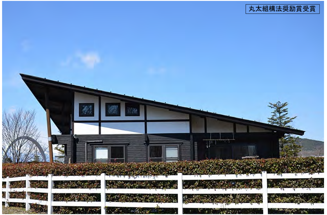
長野県安曇野市 角ログ 120×180 牧場の管理棟として国産杉ログハウスを建築。 広大な牧場に柿渋色の古風で重厚な佇まい。
