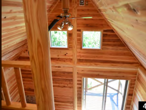
1 P&Bならではの柱と梁にマシンカットログを使用 2 外壁はレンガと漆喰 3 コンパクトながらも無駄のない住み心地にこだわりました 4 贅沢にも躯体の半分を吹抜けにし、開放感と自然光を取り入れられる設計です
