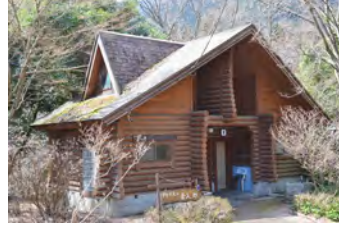
山梨県伊奈ヶ湖 公衆トイレ
