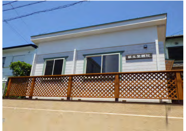
22条地域に建築。外壁、軒裏は不燃材・防火認定のログを使用しています。
