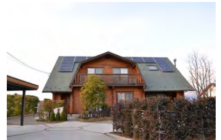
角ログ住宅 屋根南面には太陽光を設置 オール電化に対応。
