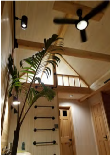
▲2Fフロア 梯子はガス管を使っています。
