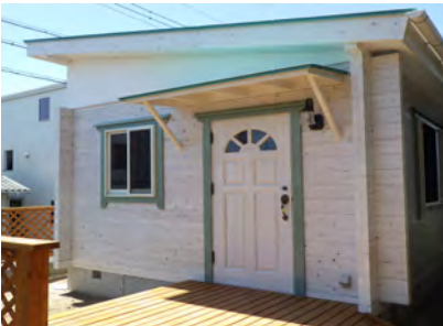
診療所ということで外壁を白色に塗装。屋根と窓枠をターコイズブルーにて塗布。
