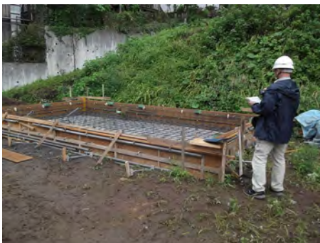
日本住宅保証検査機構JIO：基礎配筋検査
