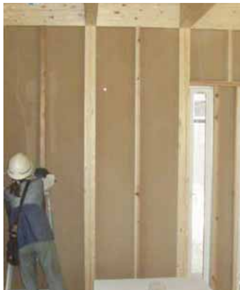
このパネル上に断熱材を吹きつけます
